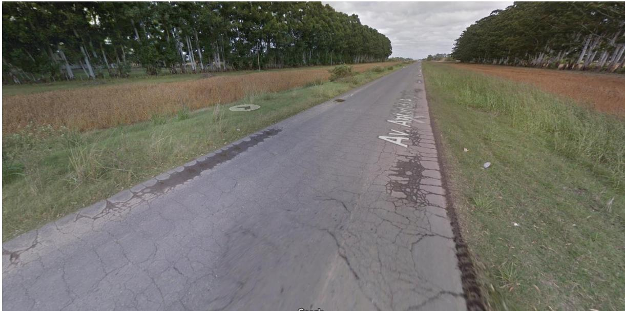
Imagen 3. Deterioro en la Av. Antártida Argentina Cno. 038-04. Partido de Zárate.
